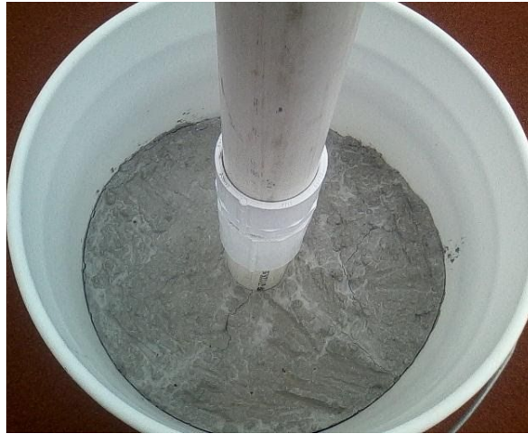
Figura 4.1: Base de cubeta con cemento para el poste.
